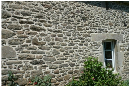
Exemple de joints extérieurs chaux/sable
