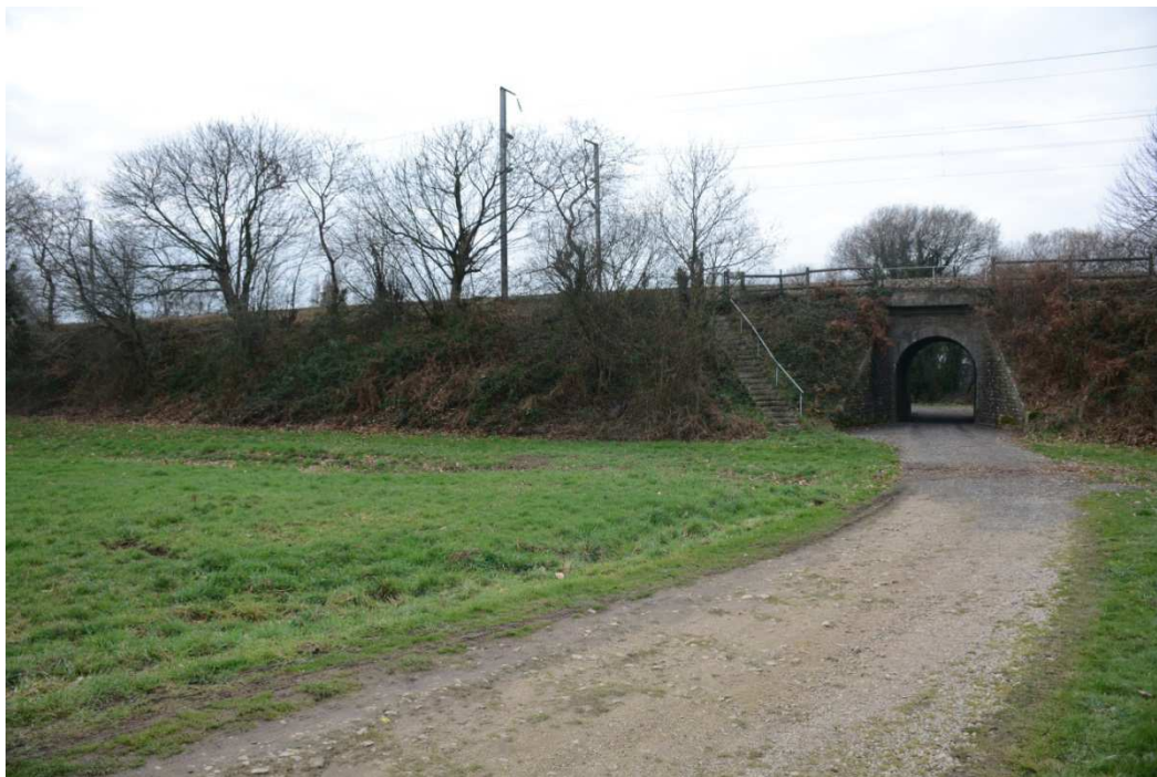
Passage ponctuel sous la voie ferrée, Gestel
