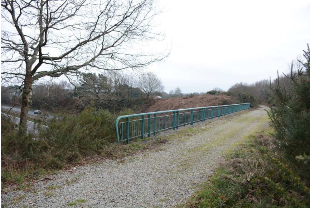
Pont permettant le passage de la N165, Gestel Source : Lorient Agglomération, 2017
