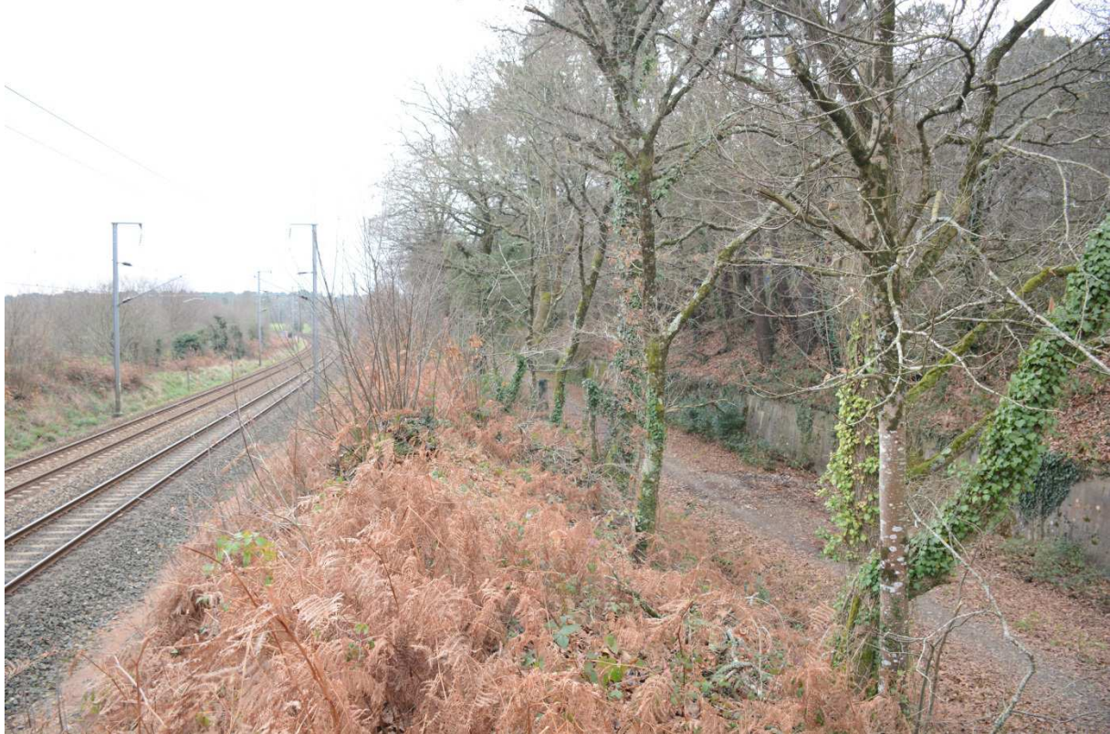
Cumul de trois ruptures linéaires liées à la voie ferrée, Gestel
