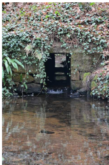
Seuil en paliers aménagé sur le ruisseau du Pont-er-Ber, route de Pont-er-Ber, Gestel
