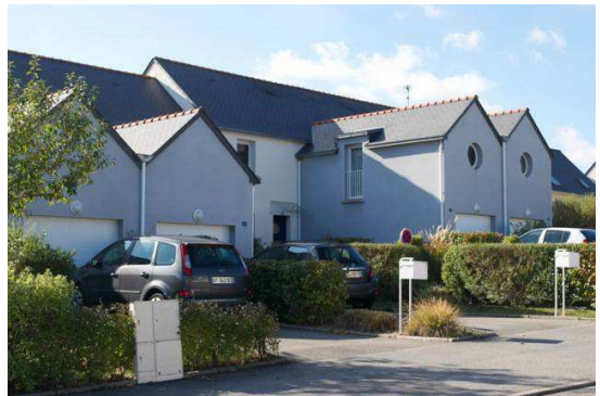
Gestel, Résidence des Bruyères.
