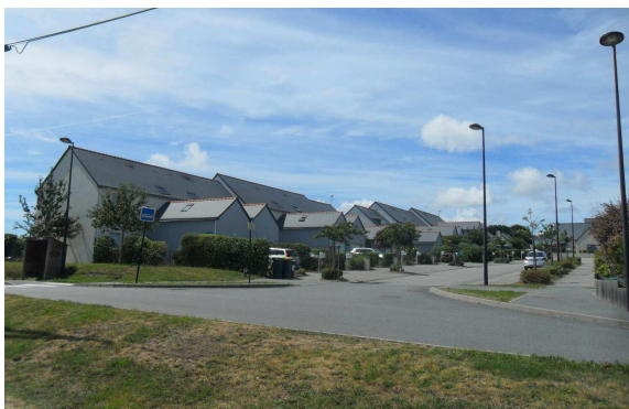
Gestel, Résidence des Bruyères.
