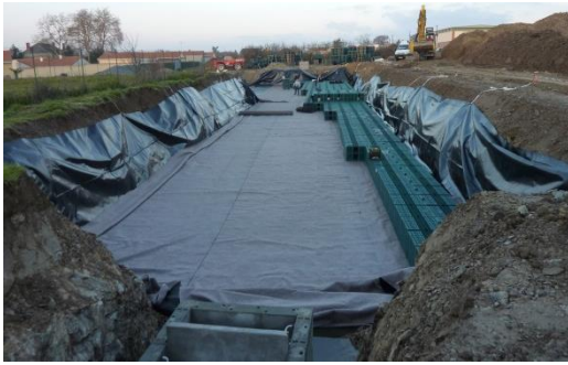
Bassin de rétention
