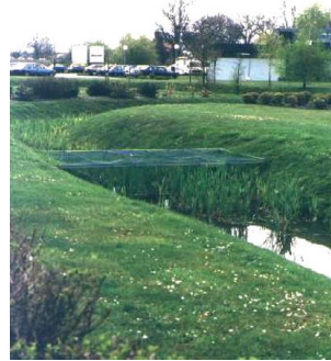
Bassin de rétention
