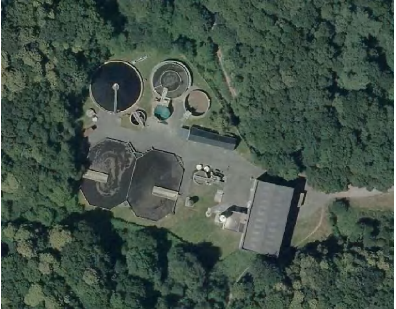
Figure 24 : station d'épuration de Quéven - Source : Orthophoto - 2016
