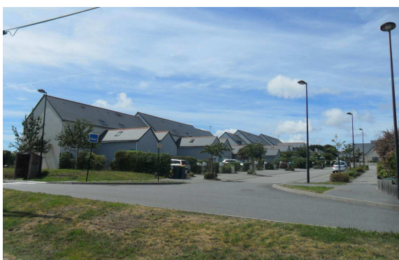
Gestel, Résidence des Bruyères.
