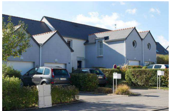
Gestel, Résidence des Bruyères.
