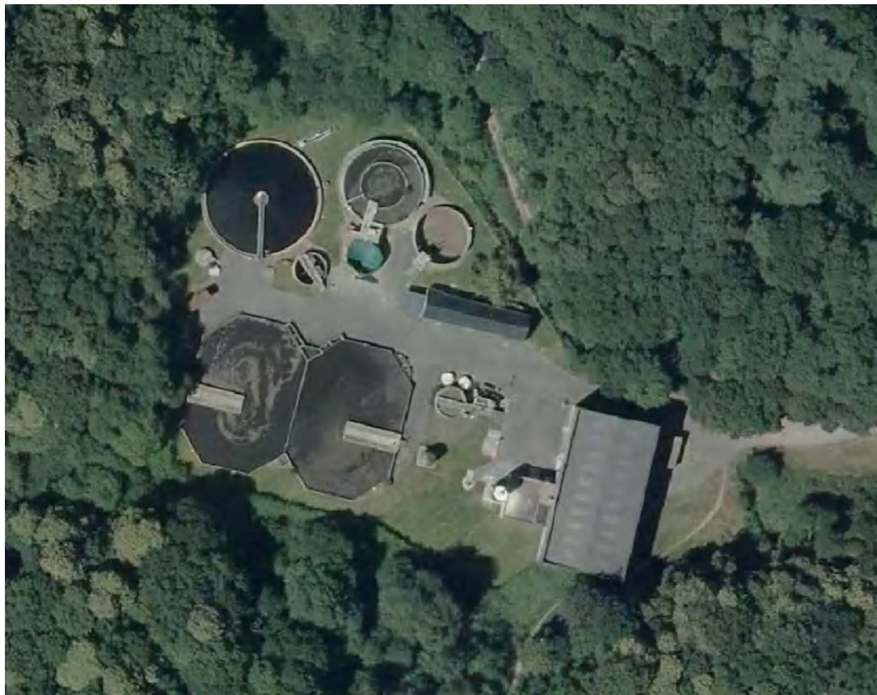
Figure 24 : station d'épuration de Quéven - Source : Orthophoto - 2016
